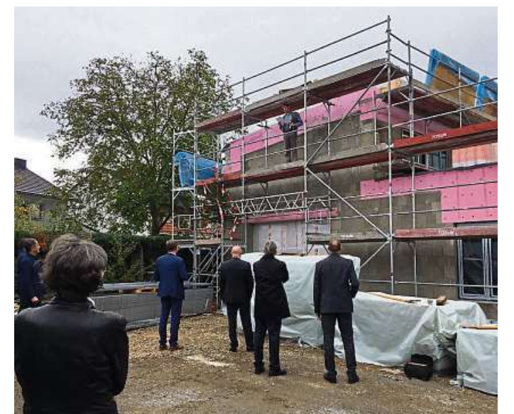
Richtfest an der Friedrich-Dessauer-Schule: In der neuen Halle entsteht ein Technologiezentrum.
